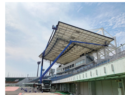
スタジアム防鳥ネット工事
