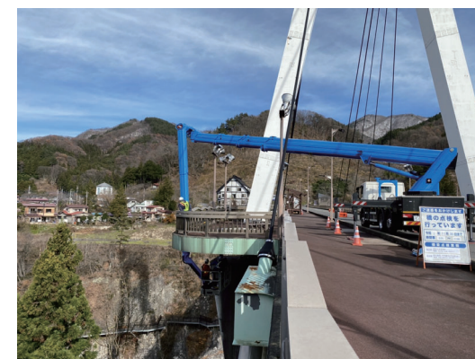
斜張橋歩道張出部点検
