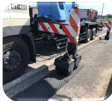
歩道の養生に
